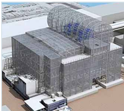
Abb. 2 Geplante Gebäudehülle für Block 4 Quelle: Tepco/WNA
