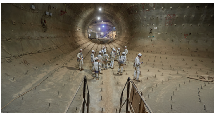
Ein Grubennebenraum im Bereich der Versatzaufbereitungsanlage. Die Außenschale ist komplett fertiggestellt.
