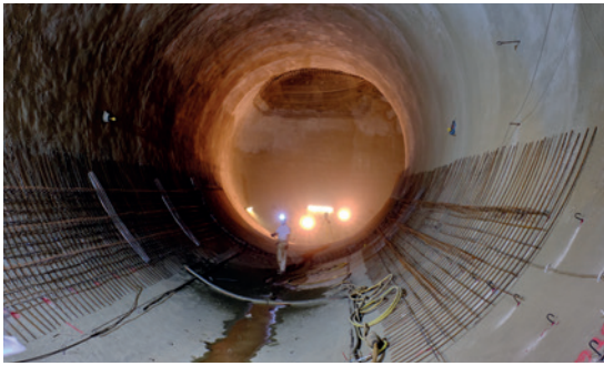
| Versatzaufbereitung – Auf die fertige Außenschale wird die Innenschale (oberer Teil fertiggestellt) aufgebracht. Mit Stahlmatten wird der Spritzbeton bewehrt.
