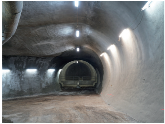
| Wendestelle und Waschplatz – hier lässt sich die fertige Innenschale betrachten.
